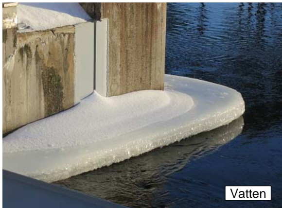
Figur 2. Vanligtvis är betongen i och strax under vattenlinjen täckt av is under vintern.
