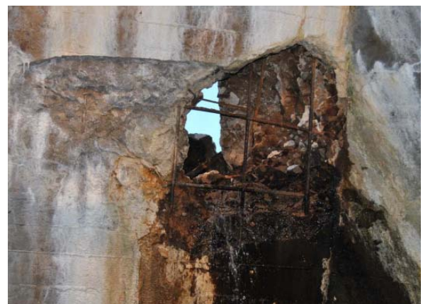
Figur 7. Ett genomgående hål (0,8 m i bredd och 1,2 m i höjd) i en allvarligt skadad betongdamm.
